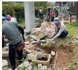
集水のための土溝づくり
